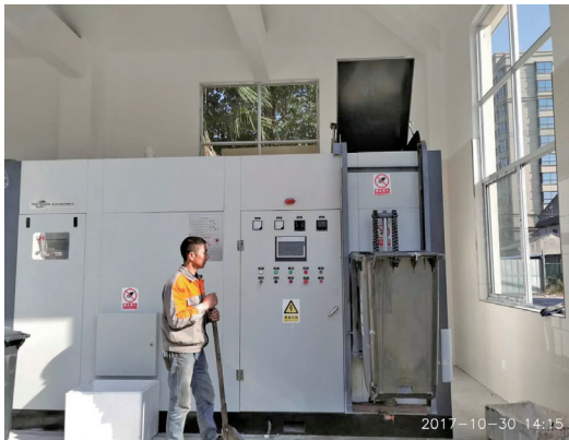
緑華オリジナル廃棄物処理システム (2)有機廃棄物堆肥処理機
