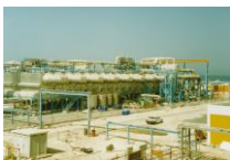
海水淡水化プラント
