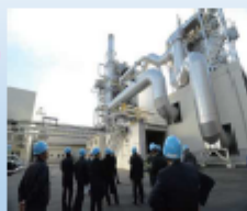
バイオマス発電所 (H29環境白書より)
