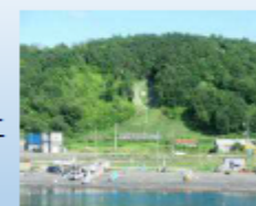
土砂崩壊防備保安林 (環境省HPより)
